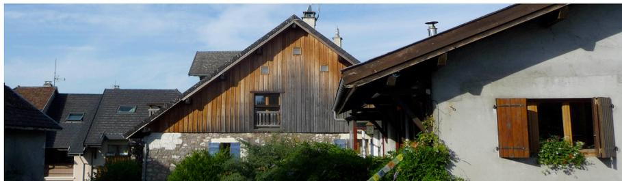
"Revêtement extérieur ou paroi sans ouvertures, sous le toit, fixé sur l'ossature, qui a pour fonctions l'esthétique et la protection du bâtiment", le bardage, présent essentiellement sur les corps de fermes et anciennes granges devenues habitations, est un élément notable de la construction à considérer pour la dimension colorée importante qu'il apporte à la construction.
