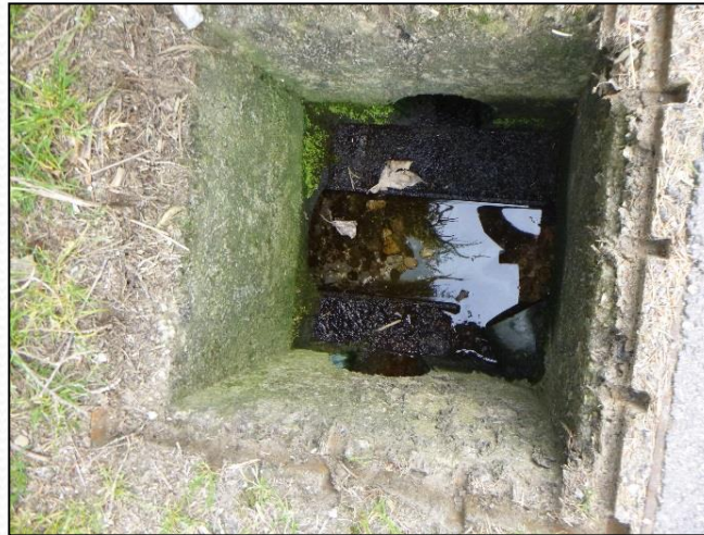
Busage et grille qui s'obstruent en face du n° 1291 route de Chosal
