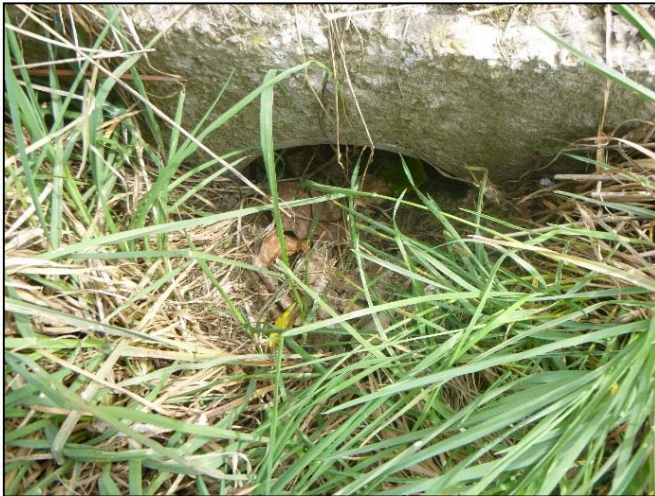
Busage et grille qui s'obstruent en face du n° 1291 route de Chosal
