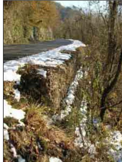
**Figure 14 :** *Vue sur les gabions et mur de soutènement de la route d'accès aux Goths.*
